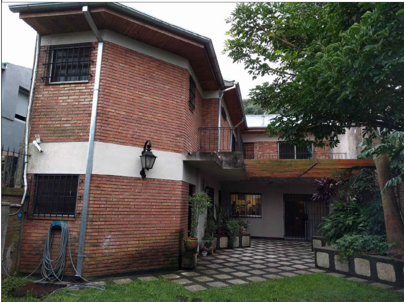
Fotografía 2, Contrafrente - Canaleta 1.2 y caños de bajada hasta Planta Alta.
